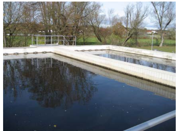
Abbildung 16: SU-Becken in der V-/A-Phase
