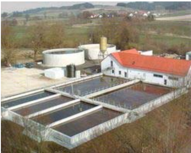
Abbildung 10: Luftbildaufnahme der Kläranlage Petershausen [12]
