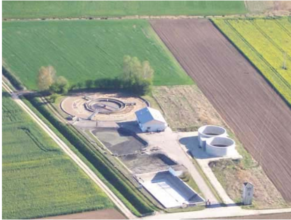
Abbildung 26: Luftbildaufnahme der Kläranlage in Buxheim [38]
