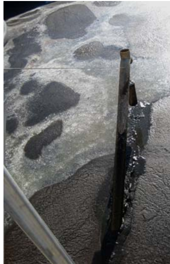
Abbildung 21: Absenken des Abzugrohres
