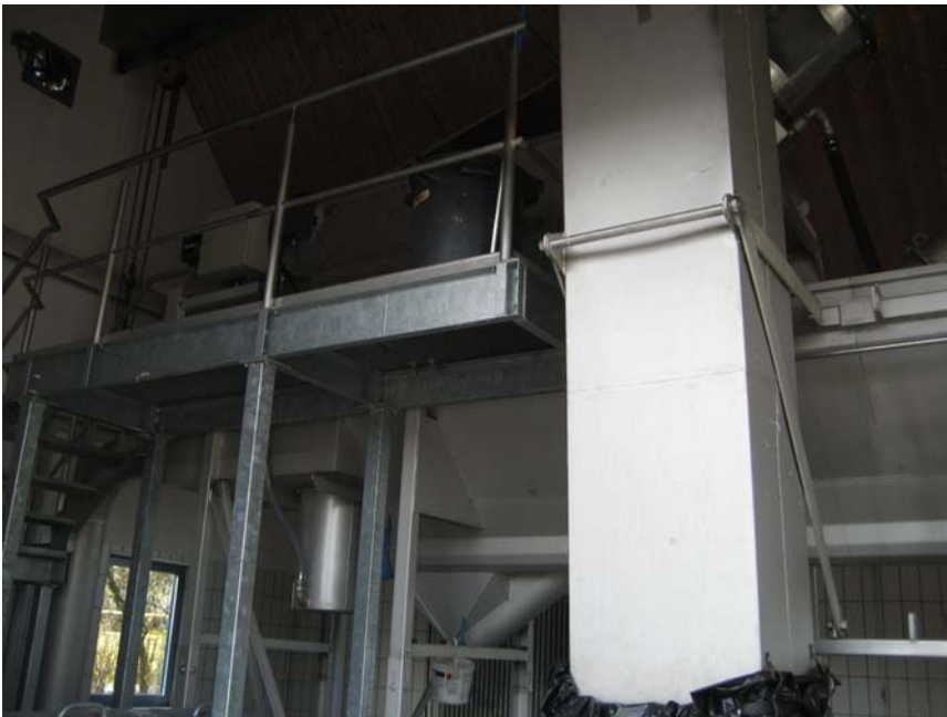
Abbildung 14: Sieb-Sandfang-Kompaktanlage
